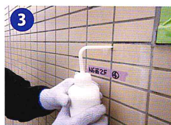
タイルが浮いている個所の上部複数の目地に、注入穴を開け、ミラクルプライマー ® MP-1000 を注入する。
