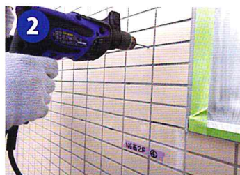
タイルが浮いている個所の上部複数の目地に、注入穴を開け、ミラクルプライマー ® MP-1000 を注入する。
